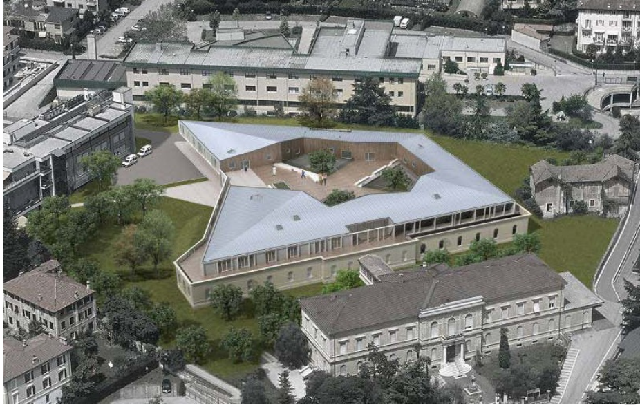
Riva del Garda, Casa di riposo LEED Italia - ORO
