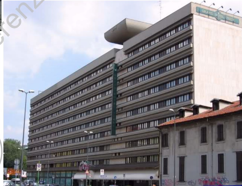
Milano, Gioia 8 LEED 2009 Core&Shell - PLATINO
