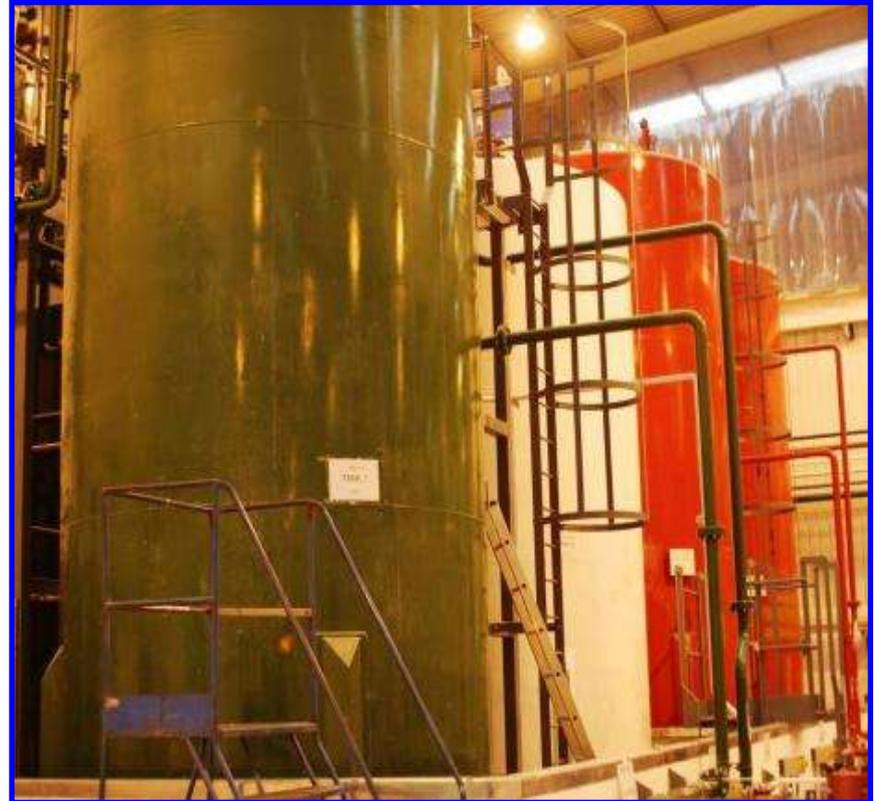
**Serbatoi di stoccaggio delle materie prime PU**
