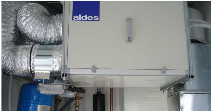
Ventilazione meccanica (portata massima 470 m<sup>3</sup>/h) con recuperatore di calore (>90%)
