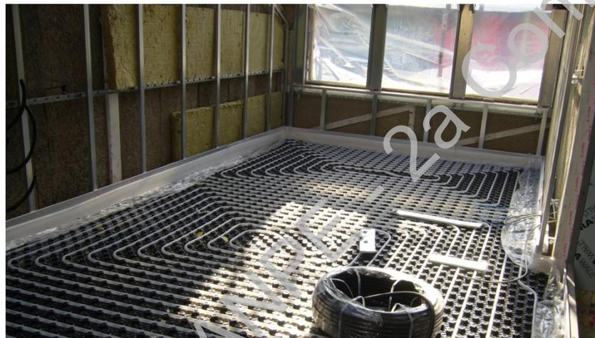
Riscaldamento (90 W/m<sup>2</sup>) e raffreddamento (30 W/m<sup>2</sup>) radiante a pavimento
