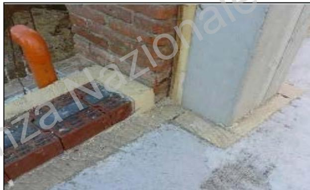
Impiego di pannelli in POLIURETANO per isolamento strutture e correzione ponti termici con ottenimento ottime prestazioni di trasmittanza termica, con minori spessori rispetto ad altri materiali
