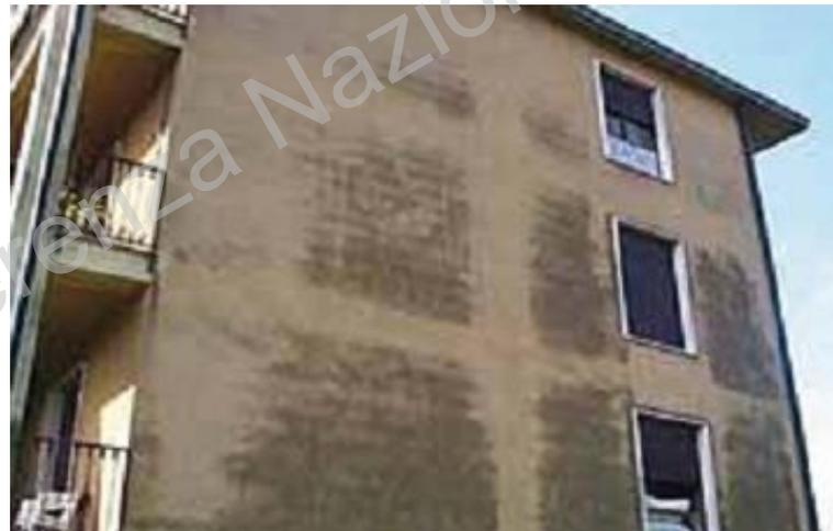
Ponti termici in evidenza esaltati da un isolamento in intercapedine: travi e pilastri non isolati si traducono in buchi di calore generando dispersioni termiche e patologie strutturali.
