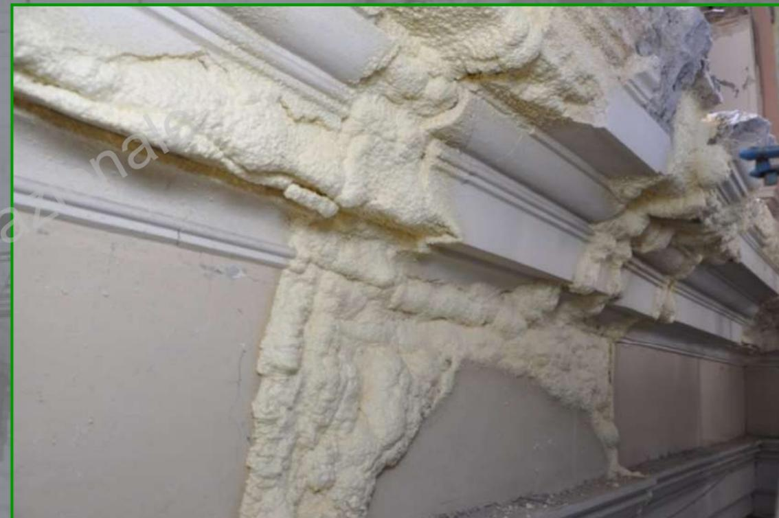
Sigillatura provvisoria delle lesioni sul fronte interno della facciata del transetto con schiuma di poliuretano.
