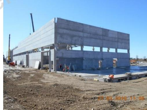
**L'ingombro dei pannelli prefabbricati è di essenziale importanza per ottimizzare la fase economica in quanto il trasporto dei componenti incide sensibilmente sull'ottimizzazione del processo di produzione, trasporto e costruzione in cantiere.**
