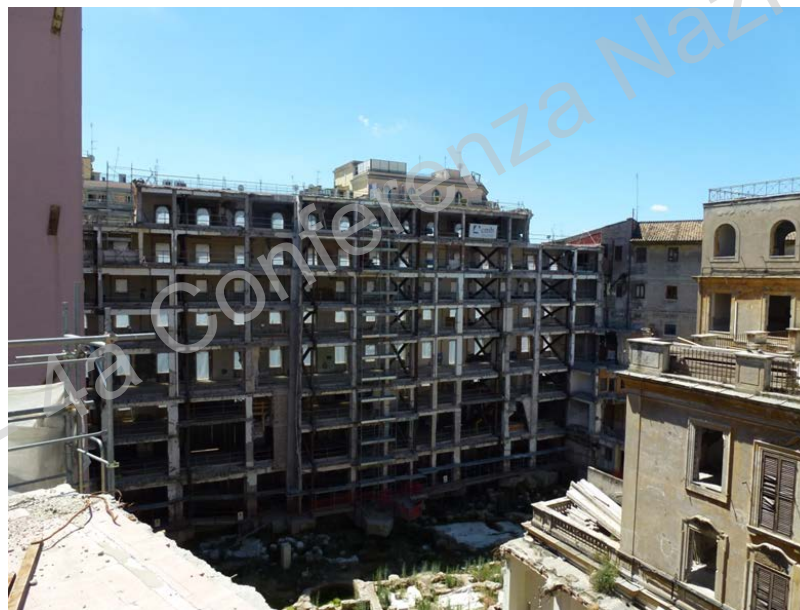
MANTENIMENTO CAMPATA STRUTTURALE IN FASE DI CANTIERE
