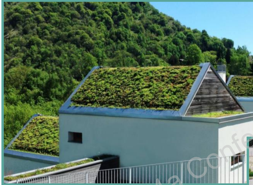
Tetto Verde «ESTENSIVO»
