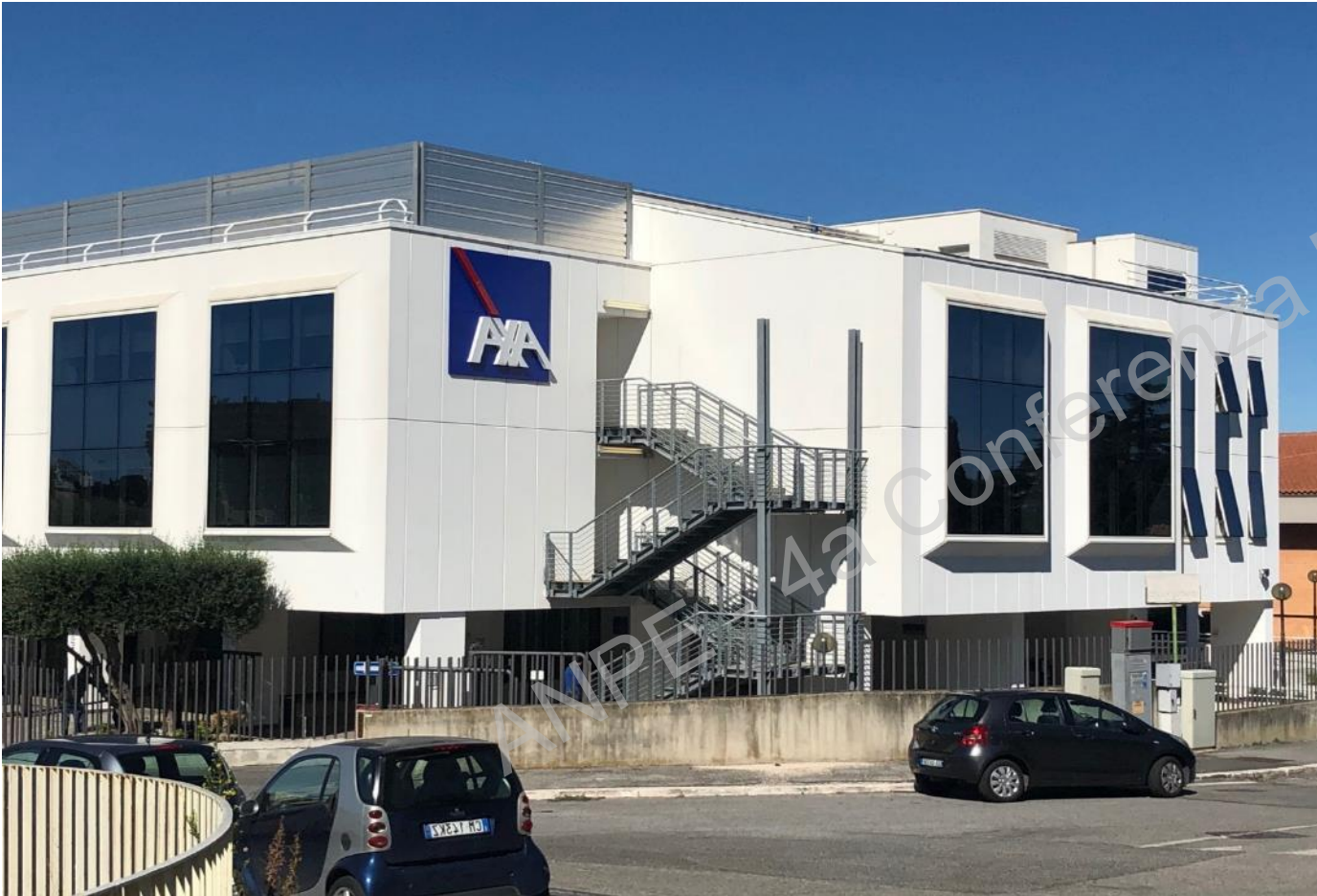
Sede AXA Roma Pannelli per isolamento pareti
