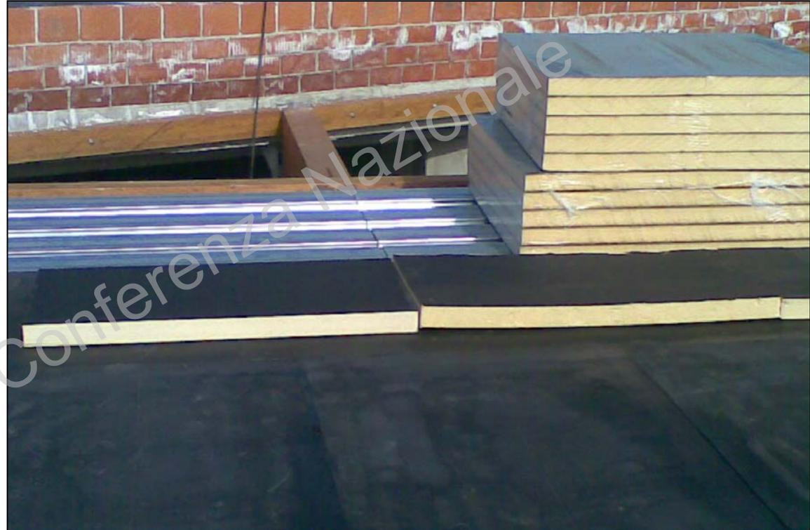
Pannelli con rivestimenti organici - se non adeguatamente protetti - possono subire deformazioni anche nel breve periodo a causa dell'igroscopicità del rivestimento.
