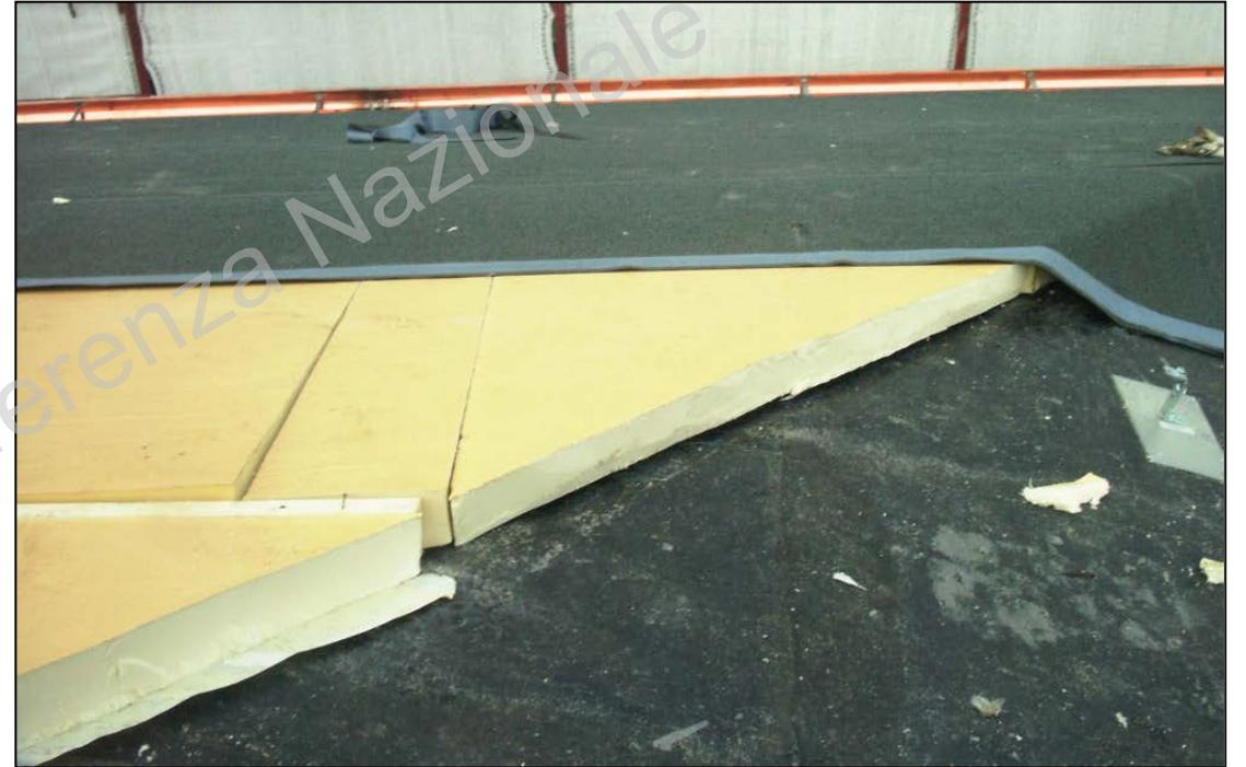
Pannelli con rivestimenti inorganici hanno dimostrato il loro basso assorbimento d'acqua ed il mantenimento delle caratteristiche fisiche anche in caso di prolungata (ed errata) esposizione alle condizioni ambientali esterne prima del completamento dell'impermeabilizzazione
