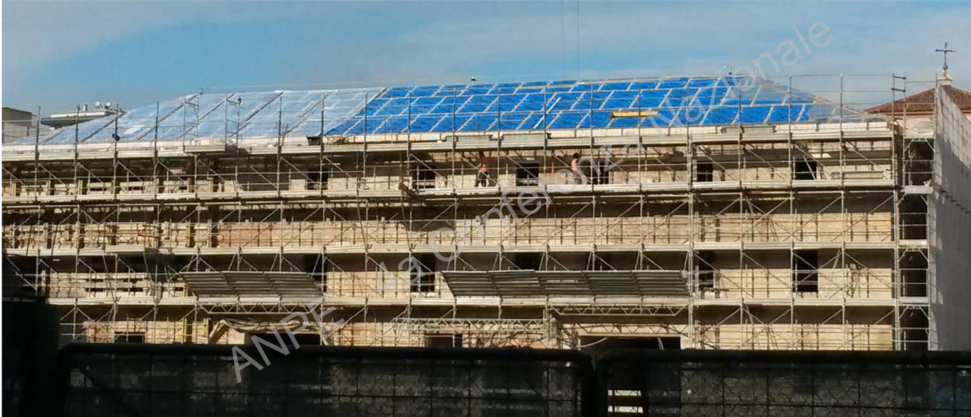
Pannelli con rivestimenti inorganici hanno superato la criticità di opere di copertura ritardate di circa 6 mesi. I pannelli non hanno subito deformazioni e si sono riscontrati distacchi solo sui nastri di sigillatura.
